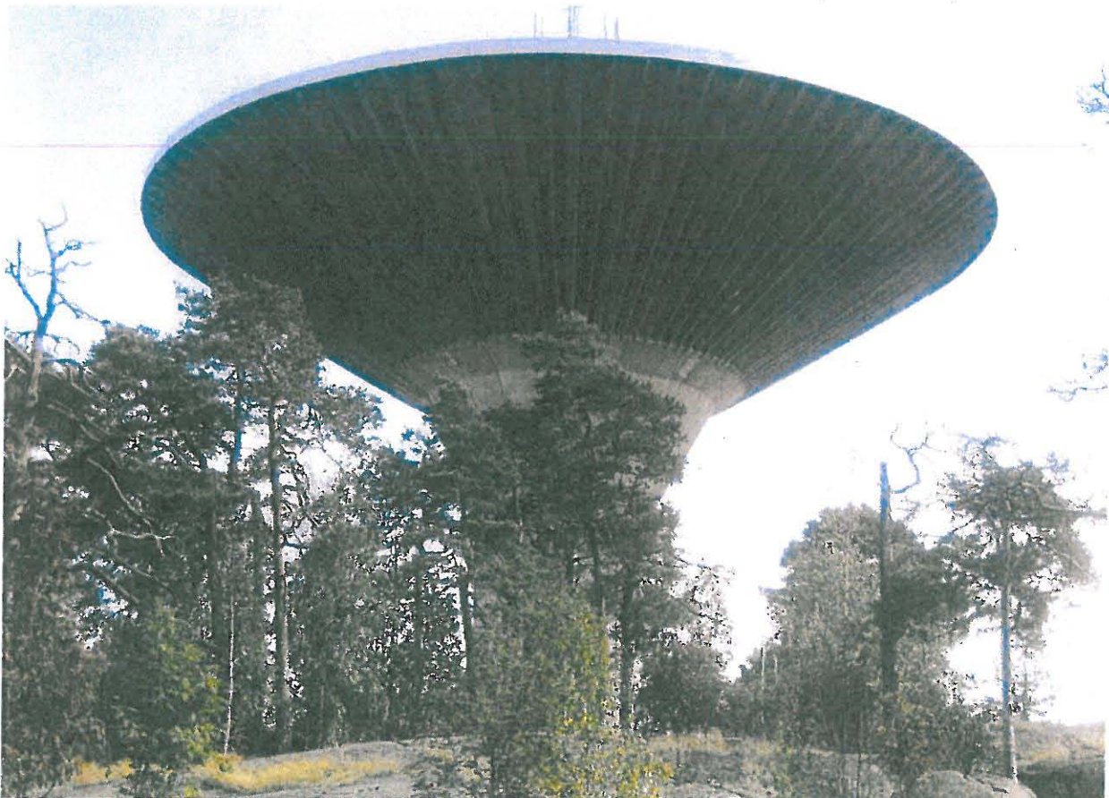
Kuvassa on vesitornirakennus länteen päin.
